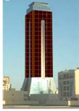
أشكال مختلفة للخلايا الفولطاضوئية على برج المؤيد لها القدرة على مد البرج 20% من كهرباء الشمس مخفضة في ذلك أطناناً من ثاني أكسيد الكربون
