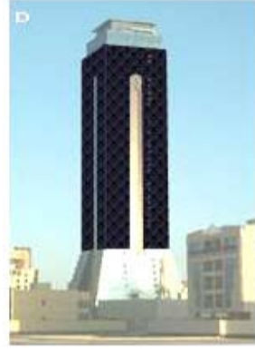
أشكال مختلفة للخلايا الفولطاضوئية على برج المؤيد لها القدرة على مد البرج 20% من كهرباء الشمس مخفضة في ذلك أطناناً من ثاني أكسيد الكربون
