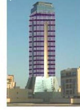
أشكال مختلفة للخلايا الفولطاضوئية على برج المؤيد لها القدرة على مد البرج 20% من كهرباء الشمس مخفضة في ذلك أطناناً من ثاني أكسيد الكربون
